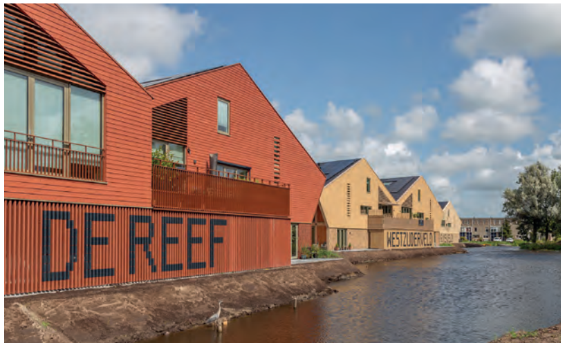
Net als bij de oude houtloodsen zijn op de kop van de blokken namen aangebracht.
