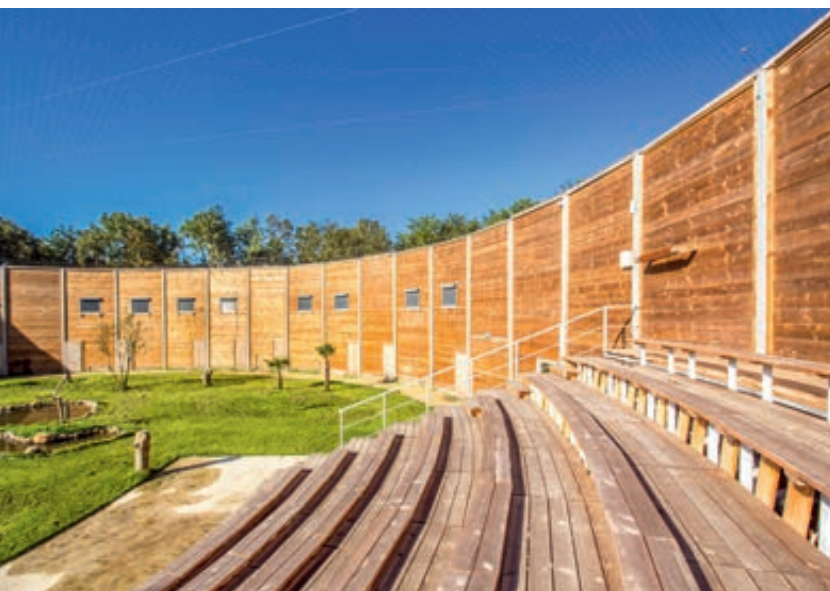
De omringende houten muur vormt de achterzijde van alle volièrès. De tribune volgt de ronding van de muur.
