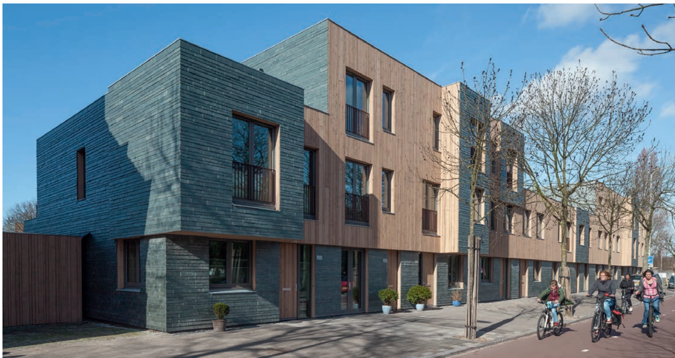
Poot langs de Mient. Het ruwe horizontaal georiënteerde leisteen en het fijnbezaagde verticale hout zorgen voor een weerbarstig-sierlijke balans.
