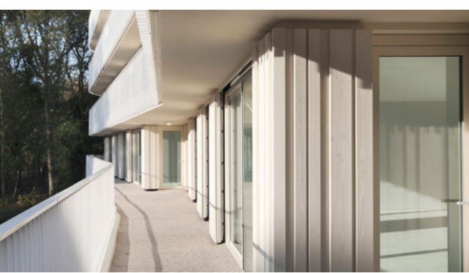
Verticaal opdekwerk in Duits douglas met vier breedtematen: 65/95/140/180 (x 25 mm).
