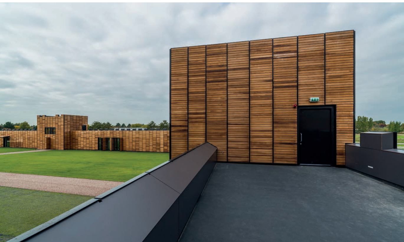
De omloop op de omwalling voert dwars door de torens; hierin zitten vertrekken voor vergaderen of exposeren.
